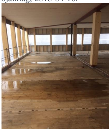
Bild 13. Många vattenpölar på bjälklaget, etapp 1, 2018-06-18.
