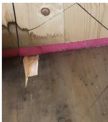
Bild 21. Uttaget prov av ovansida bjälklag under sylomer. Synliga fuktmarkeringar på nederkanten av väggen samt att bjälklaget blivit missfärgat av bland annat missfärgat vatten.
