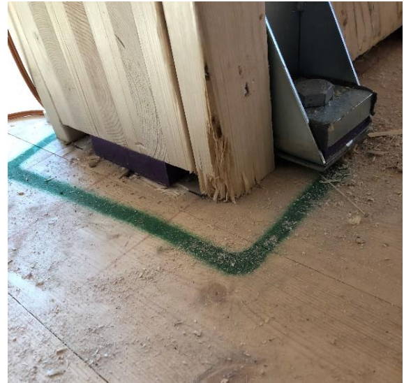
Bild 20. Hus 3, innerväggen var placerad på en sylvomer.
