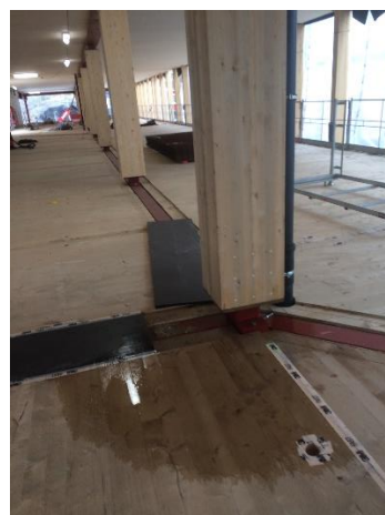
Bild 12. Vatten på bjälklag, våning 3, 2018-04-16.
