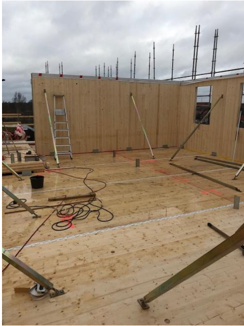
Bild 25. Hus 3, plan 6. Pågående stomresning och vatten på bjälklag, 2019-02-19.
