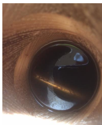
Bild 14. Stående vatten i infästningshål.
