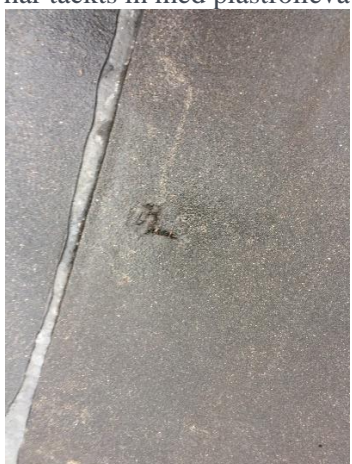
Bild 11. Hål har uppkommit i takpapp på terrassbjälklag, 2018-04-16.
