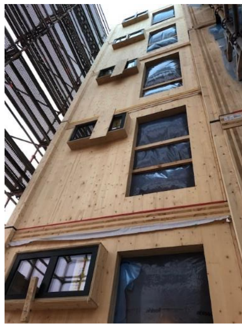
Bild 18. Hus 2, utsida ytterväggsstomme, 2019-02-19.
