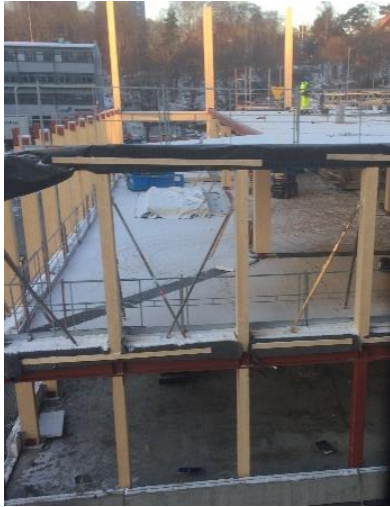
Bild 1. Pågående montage av plan 3, 2018-02-22
