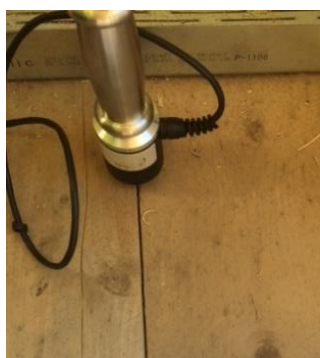
Bild 19. Fuktkvotmätning i springa i bjälklag med hammarelektrod.
