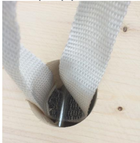
Bild 4. Infästning för lyftögla.
